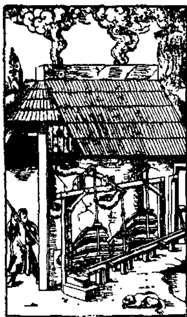
Рис. 5. Мех с приводом от водяного колеса
