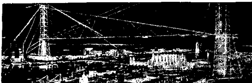
Рис. 8. «Катанье в поднебесье» на Чикагской выставке. Две башни соединены морским канатом, по которому в качающихся вагонах перевозятся пассажиры
